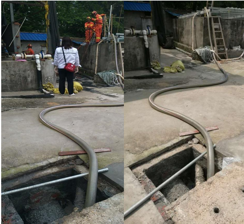
图 6 事故救援现场排水管放置方式
