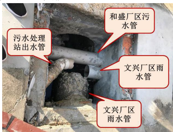
图 5 调节池东北侧雨水井内管线分布
