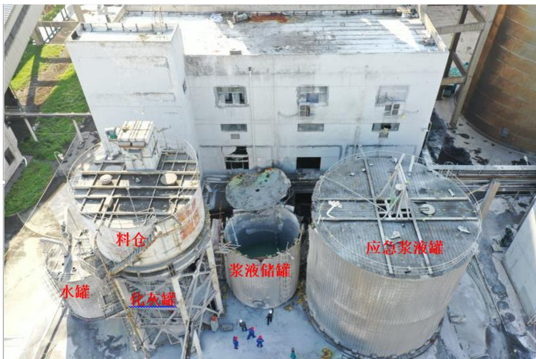
图 6 事故后现场图片
