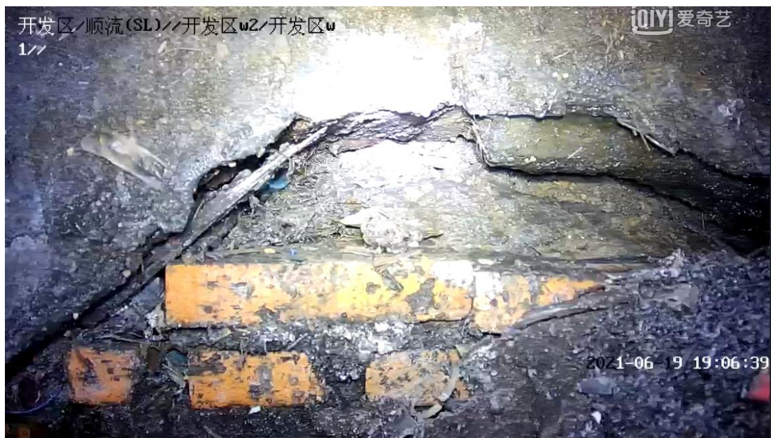
图 8 更换后的污水管道与原检查井 2 接口内部图
