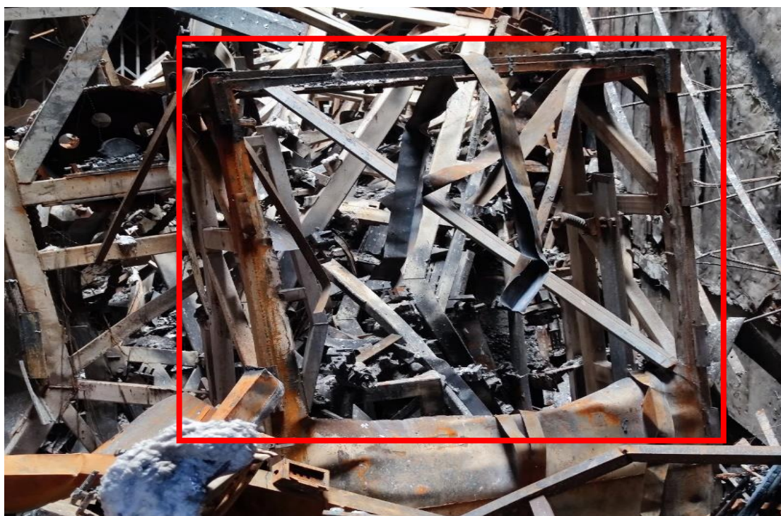
图 18 扶梯转向站底板被切割
