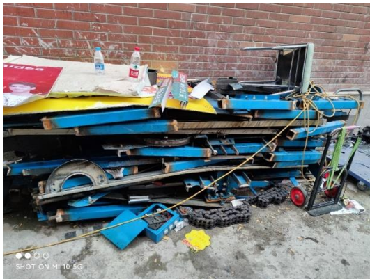
图 21 拆下的自动扶梯零部件布满油污
