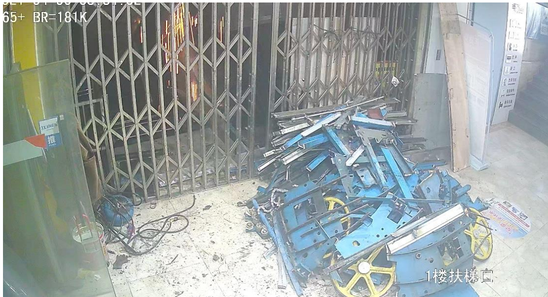
图 22 8 时 07 分起陆续有火花掉落至自动扶梯井负一层
