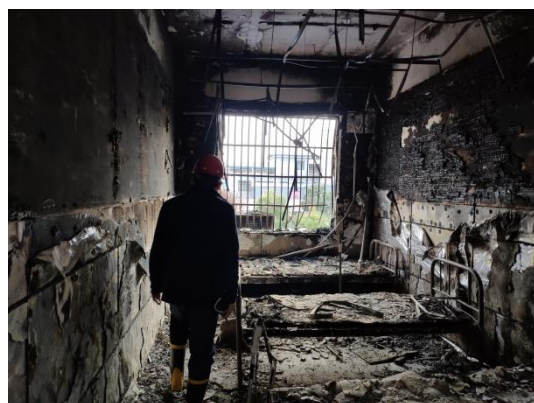
图 9 二层西侧病房窗户安装有防盗窗
