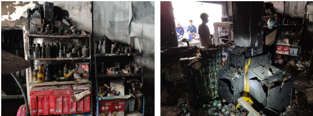
图 8 事故店铺内堆放大量易燃物品
