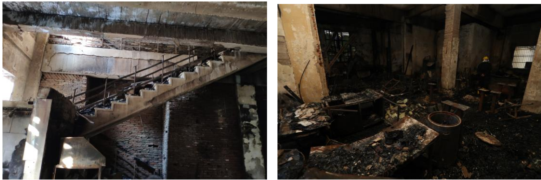
图4 一层通往二层步行楼梯被封堵 图5 一层起火店铺火灾后现场图
