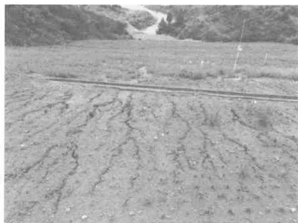
图 2-5 坝体外坡出现冲刷、拉沟现象
