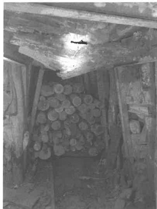
图 2-2 未及时修复受破坏的支护
